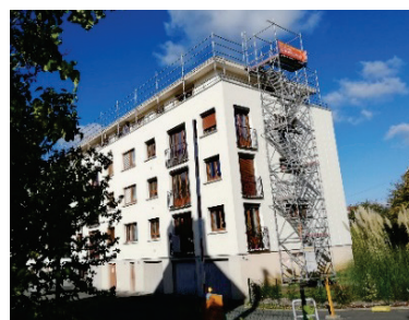
Copropriété en cours de rénovation
